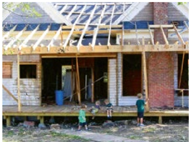
DAS FARMHAUS WÄHREND DER RENOVIERUNGEN.
